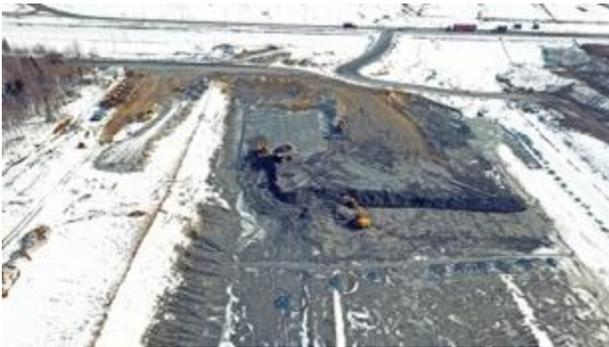
De janvier à avril 2023, l'excavation des cellules 4 et 5 de la phase 3B-1 a eu lieu. Le fond a été égalisé avec les pentes désirées afin de permettre une gestion de l'eau efficace.
