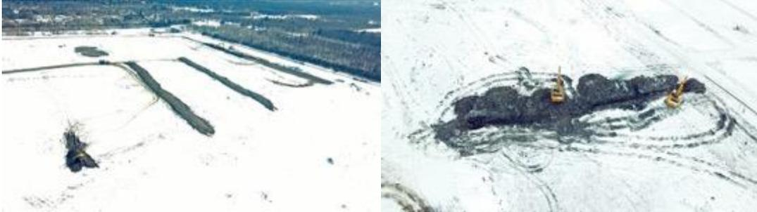
Des tranchées ont été creusées pour installer les tuyaux de biogaz, ce qui a favorisé l'exposition à l'air et donc la génération d'odeurs. Les travaux se sont terminés le 10 mars.
