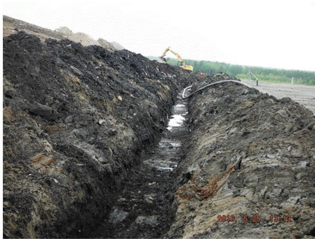
Tranchée de captage des biogaz
