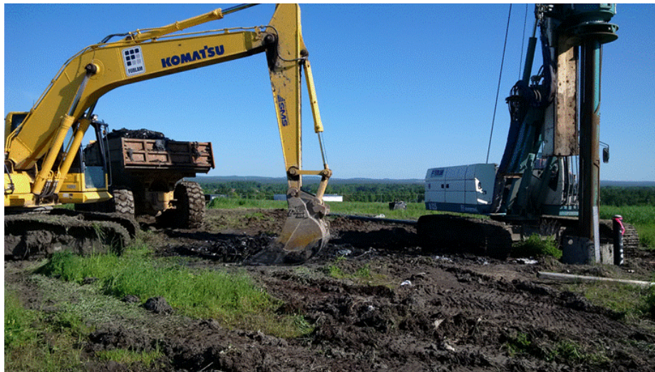
Installation de 6 nouveaux puits verticaux Cell 5 à 8
