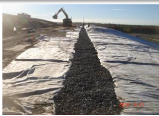
Aménagement des tranchées
